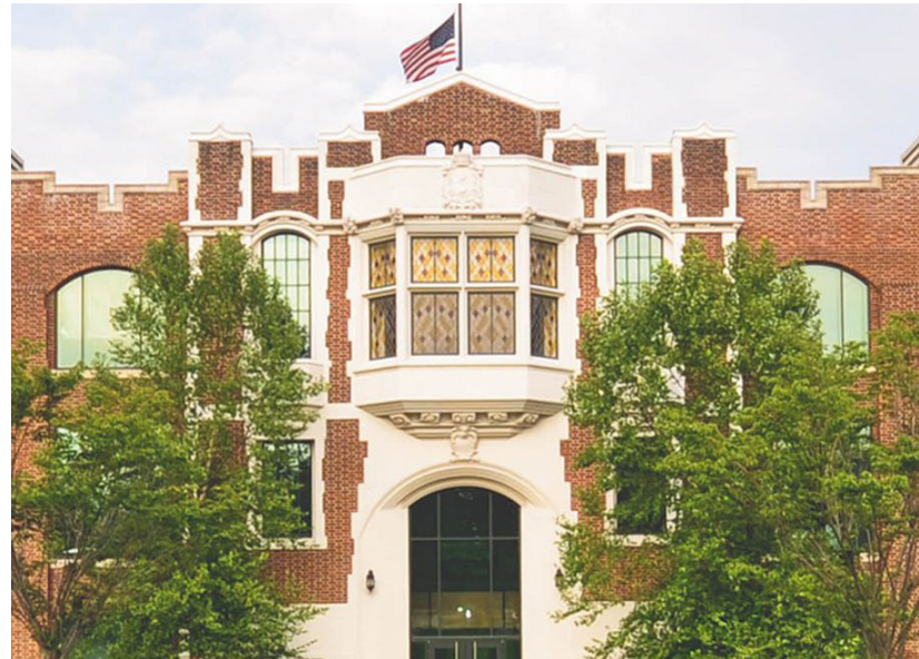
Webair NY1 Datacenter
